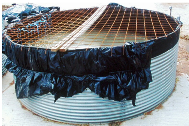
6 pav. Ruošiama kietos dangos paviršiui.
